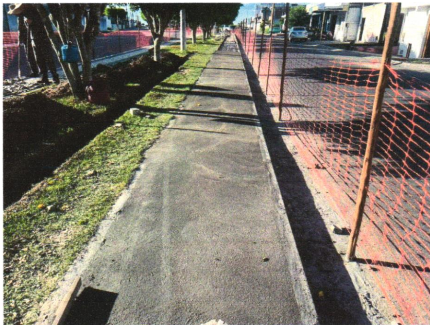
Foto 07 - PAVIMENTAÇÃO EM CONCRETO, COM ESPESSURA DE 7 CM, COM ACABAMENTO FEITO UTILIZANDO ALISADORA DE CONCRETO (HELICOPTERO), INCLUIDO TELA DE AÇO SOLDADA NERVURADA CA60, Q196 (3,11 KG/M 2 ), DIAMETRO DO FIO 5.0 MM, LARGURA = 2,45 M, ESPAÇAMENTO DA MALHA = 10 X 10 CM, JUNTA DE DILATAÇÃO EM PVC A CADA 2,00 M, CONCRETO FCK = 20 MPA
