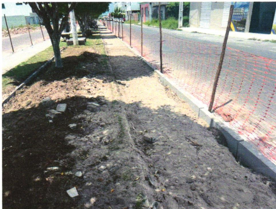
Foto 03- ASSENTAMENTO DE GUIA (MEIO-FIO) EM TRECHO RETO, CONFECCIONADA EM CONCRETO PRÉ-FABRICADO, DIMENSÕES 100X15X13X20 CM (COMPRIMENTO X BASE INFERIOR X BASE SUPERIOR X ALTURA), PARA URBANIZAÇÃO INTERNA DE EMPREENDIMENTOS. AF_06/2016_P
