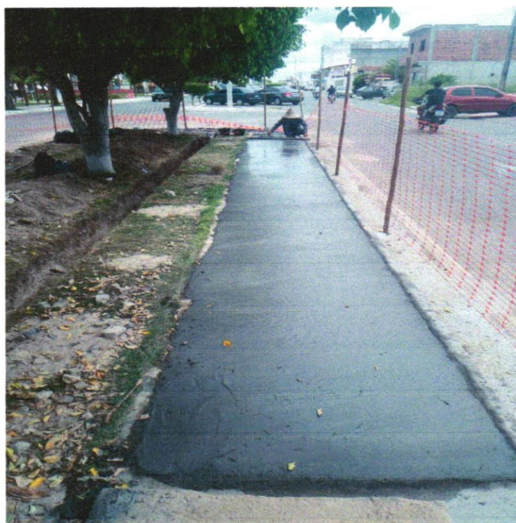
Foto 08 - PAVIMENTAÇÃO EM CONCRETO, COM ESPESSURA DE 7 CM, COM ACABAMENTO FEITO UTILIZANDO ALISADORA DE CONCRETO (HELICOPTERO), INCLUIDO TELA DE AÇO SOLDADA NERVURADA CA60, Q196 (3,11 KG/M 2 ), DIAMETRO DO FIO 5.0 MM, LARGURA = 2,45 M, ESPAÇAMENTO DA MALHA = 10 X 10 CM, JUNTA DE DILATAÇÃO EM PVC A CADA 2,00 M, CONCRETO FCK = 20 MPA
