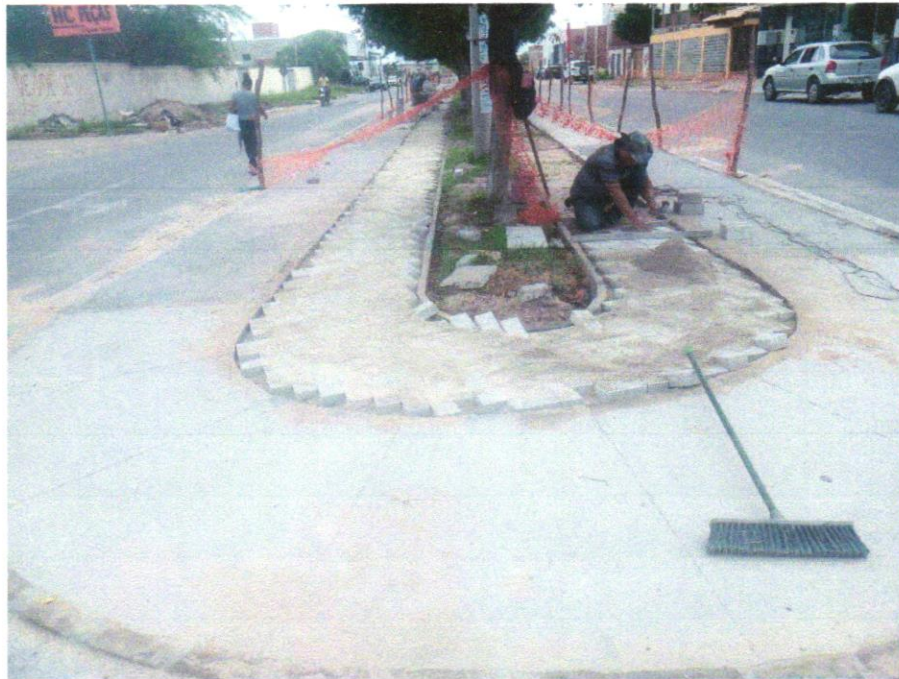
Foto 09- Pavimentação em bloco de concreto vibroprensado, intertravado, cor natural, 10x20cm, e=6cm, 46un/m 2 , NBR9781, Fck(min)=35MPa, sob coxim areia grossa compactada c/ placa vibratória, e(comp.)=6cm, rejuntado c/ areia fina.
