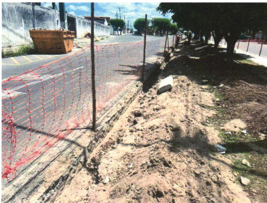
Foto 01 - ESCAVAÇÃO MANUAL DE VALA COM PROFUNDIDADE MENOR OU IGUAL A 1,30 M
