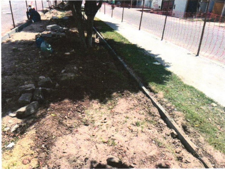
Foto 05 - ASSENTAMENTO DE GUIA (MEIO-FIO) EM TRECHO RETO, CONFECCIONADA EM CONCRETO PRÉ-FABRICADO, DIMENSÕES 80X08X08X25 CM (COMPRIMENTO X BASE INFERIOR X BASE SUPERIOR X ALTURA), PARA URBANIZAÇÃO INTERNA DE EMPREENDIMENTOS. AF_06/2016
